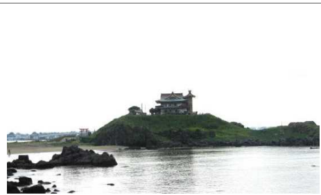
2015年11月5日未明に全焼した蕪島神社ですが、2016年11月に再建工事が始まり約5年の歳月をかけ2020年2月に工事完了。ウミネコの繁殖期である4月から8月は工事を休止したそうです。
