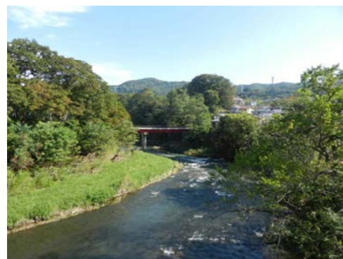
「しのぶ橋」から「岩瀬橋」を望む
